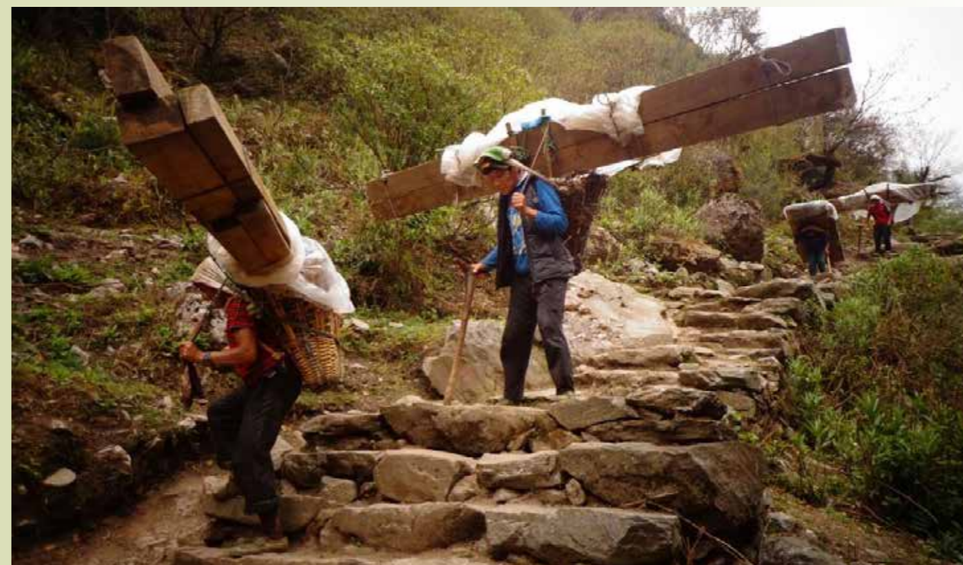
El traslado de vigas de madera por los difíciles accesos del lugar
